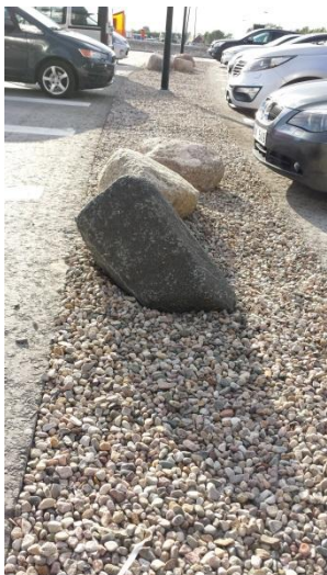
Figur 6. Exempel på mindre krossfyllt dikes/kanalmagasin.
