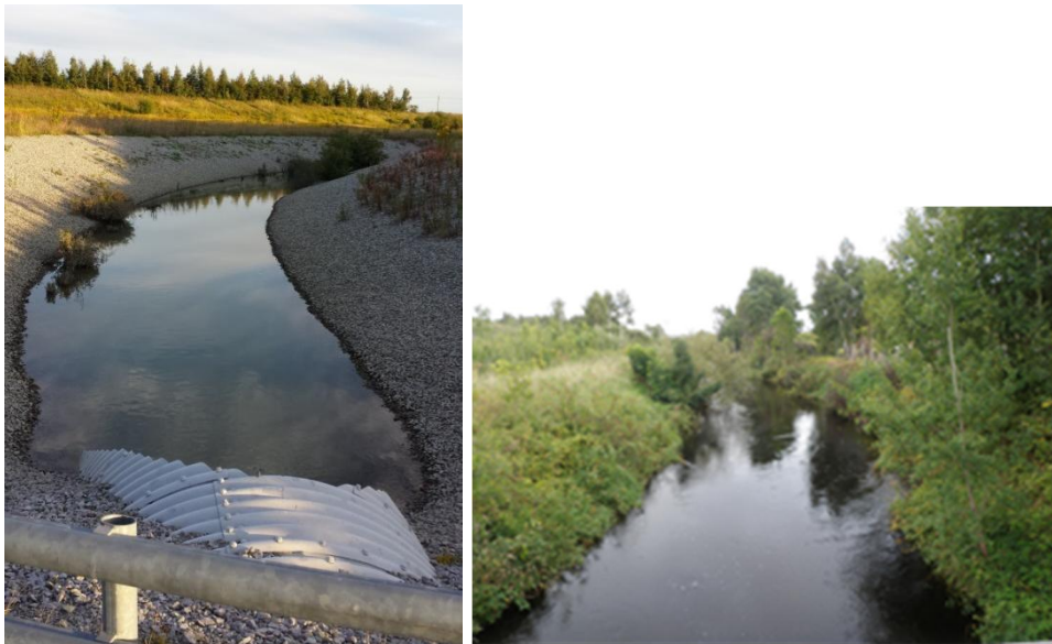
Figur 7. Exempel på hur ett fördröjningsmagasin utformat som kanal kan se ut.
